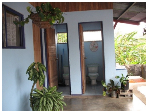
Servicios sanitarios. Foto propia
