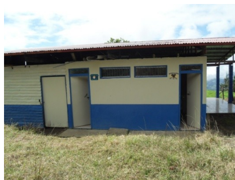
Bodega y servicios sanitarios
